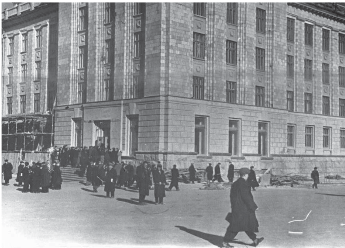
Окончание строительства восточного крыла главного корпуса ЧПИ. Здесь разместился ИС факультет в 1958 году
