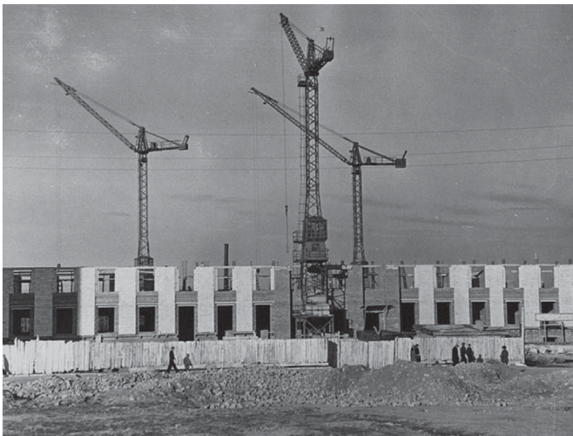
Строительство главного корпуса ЧПИ, 1955 год
