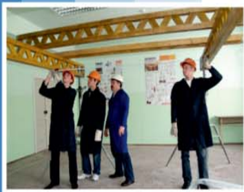
Отработка технологий монтажа опалубки PERI на полигоне
