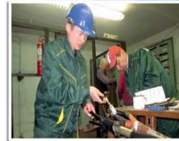
Монтаж строительной муфты
