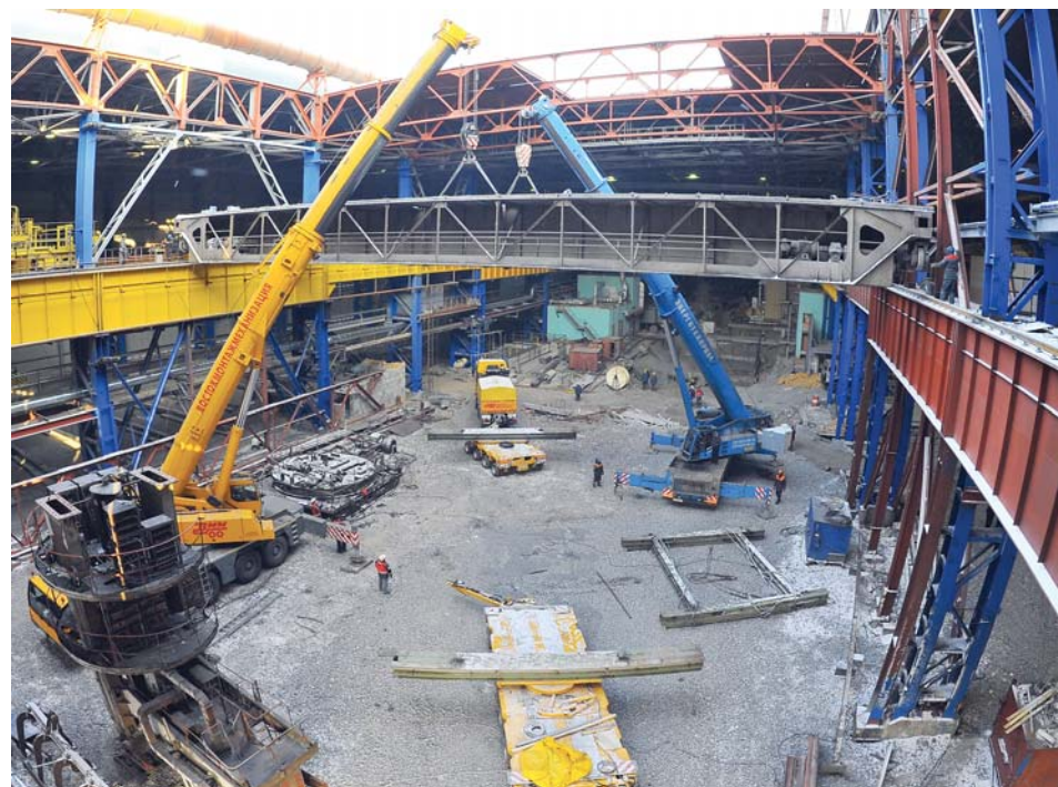
г. Челябинск, ЧМК, перевозка и монтаж пратцен-крана весом 86 тонн с габаритами 36x10 метров
