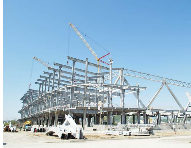
Крытый конькобежный центр, г.Сочи
