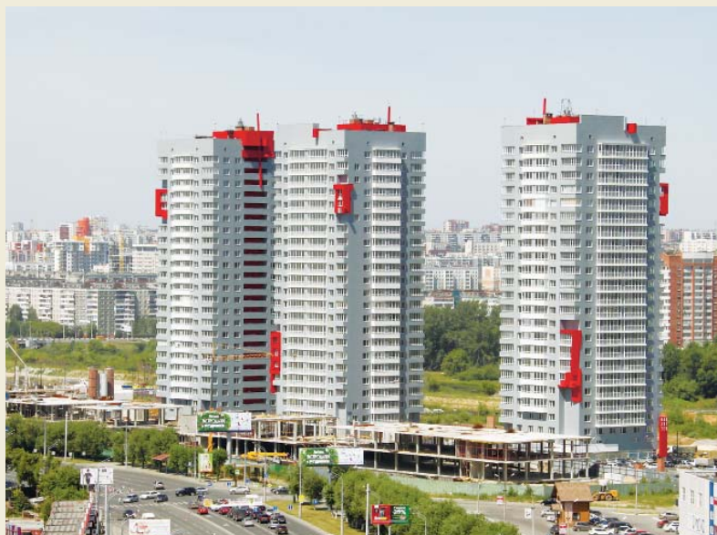
Жилой комплекс «Манхэттен» (1-я очередь), ул. Труда, г. Челябинск ЗАКАЗЧИК-ЗАСТРОЙЩИК – ООО «Новые горизонты»
