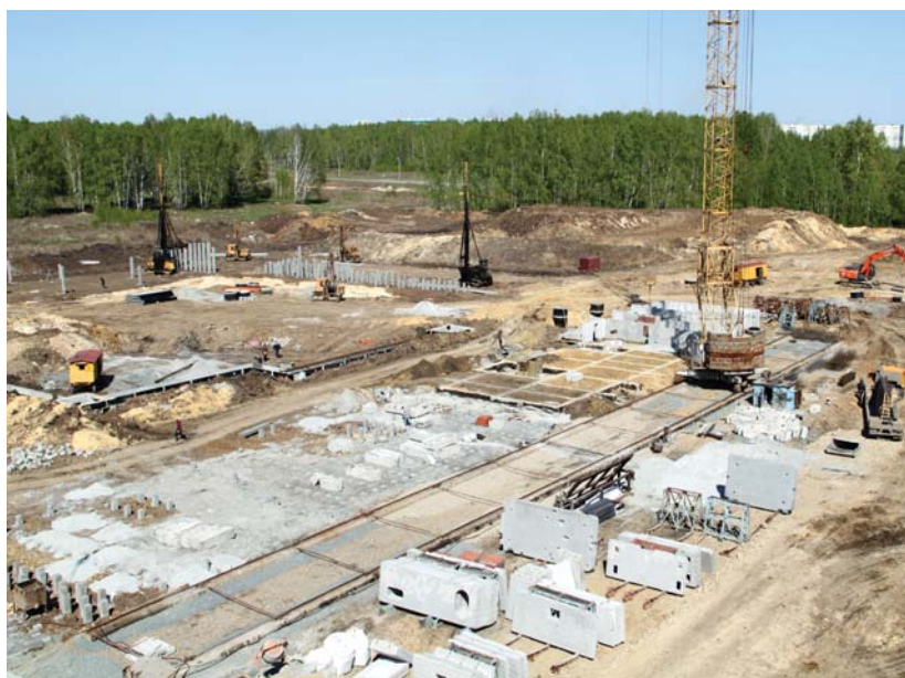
Застройка Краснопольской площадки
